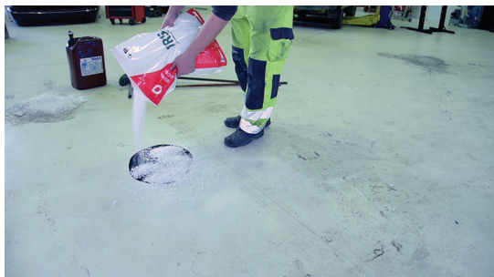
Jäteöljyvahingon poisto lattialta
